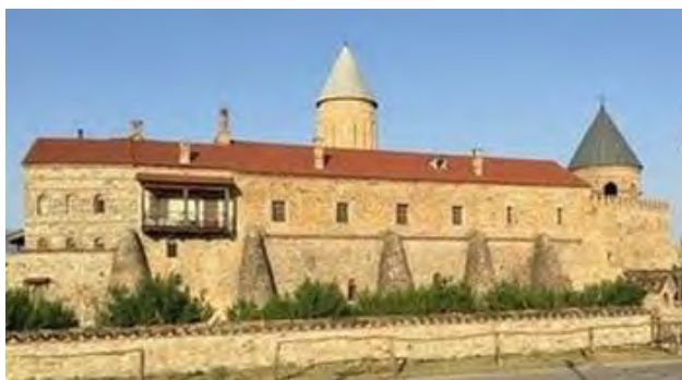
სურ. 3.23.2. გალავანში ჩაშენებული პალატი კონტრაფორტებით
