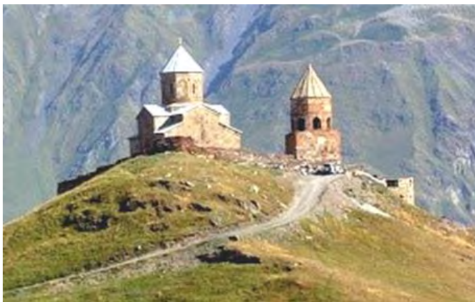
სურ. 3.131.2. საერთო ხედი
