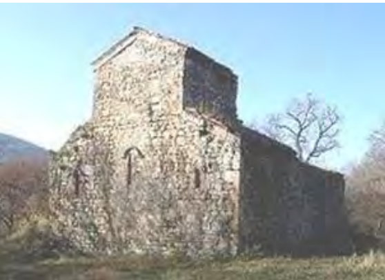
სურ. 3.51.1.1. საერთო ხედი
