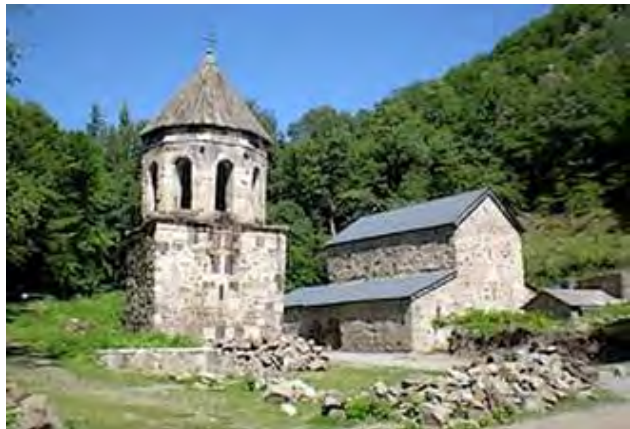
სურ. 3.49.1. საერთო ხედი
