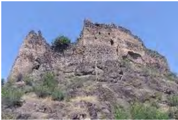
სურ. 3.92.1. საერთო ხედი
