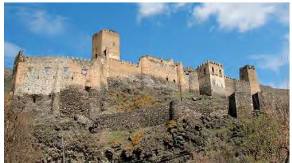
სურ. 3.94.2. საერთო ხედი
