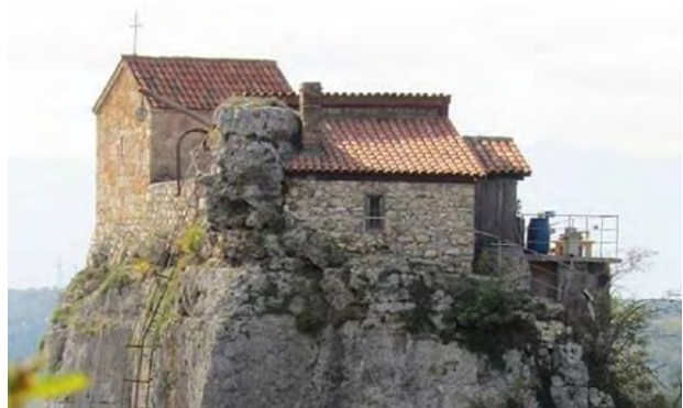
სურ. 3.115.2. საერთო ხედი
