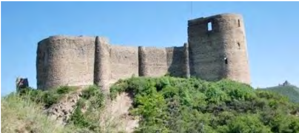
სურ. 3.97.1. საერთო ხედი
