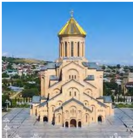
სურ. 3.157.2. საერთო ხედი
