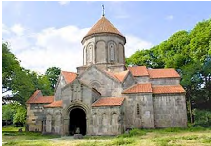
სურ. 3.88.1. საერთო ხედი
