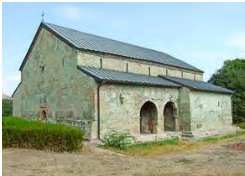
სურ. 3.13.1. საერთო ხედი
