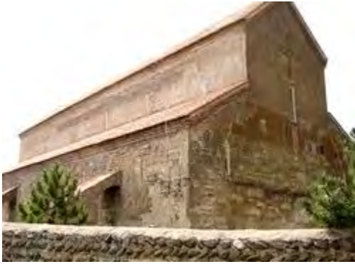
სურ. 3.37.1. საერთო ხედი
