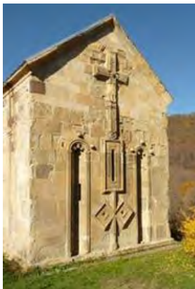
სურ. 3.110.1. საერთო ხედი
