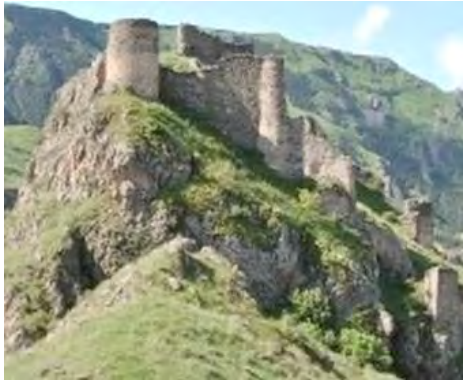
სურ. 3.52.1. საერთო ხედი
