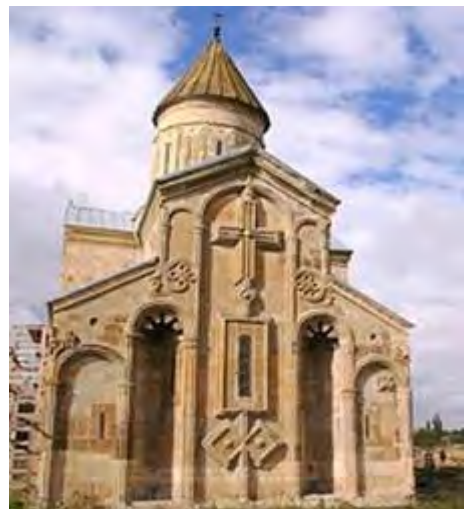
სურ. 3.77.2. საერთო ხედი
