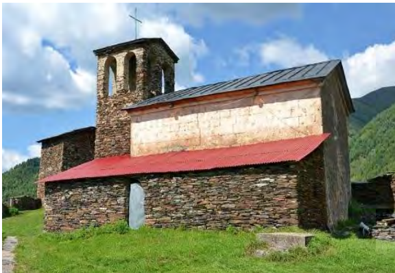
სურ. 3.67.1. საერთო ხედი
