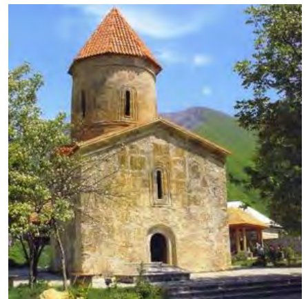
სურ. 3.65.1. საერთო ხედი
