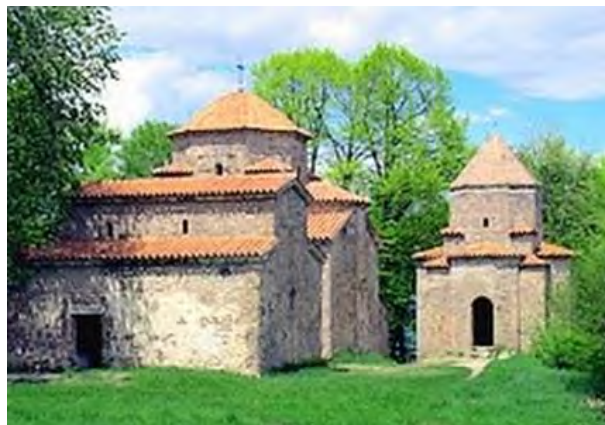
სურ. 3.38.1. საერთო ხედი
