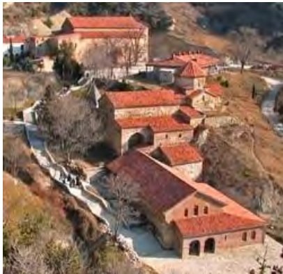
სურ. 3.21.1. საერთო ხედი
