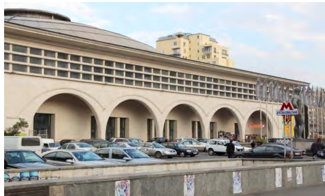
სურ. 4.8.1. საერთო ხედი
