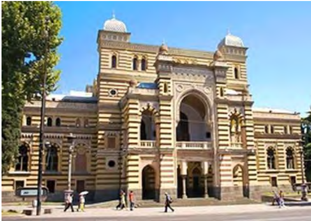
სურ. 4.5.1. საერთო ხედი
