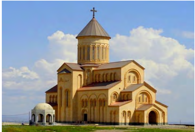
სურ. 3.161.1. საერთო ხედი
