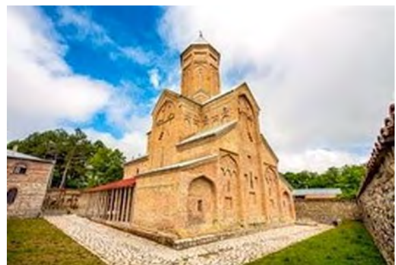
სურ. 3.135.1. საერთო ხედი
