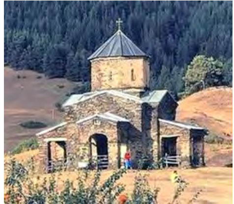
სურ. 3.151.1. საერთო ხედი
