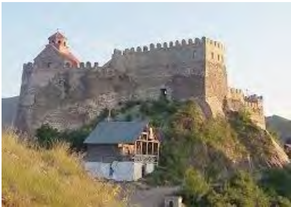
სურ. 3.70.1. საერთო ხედი
