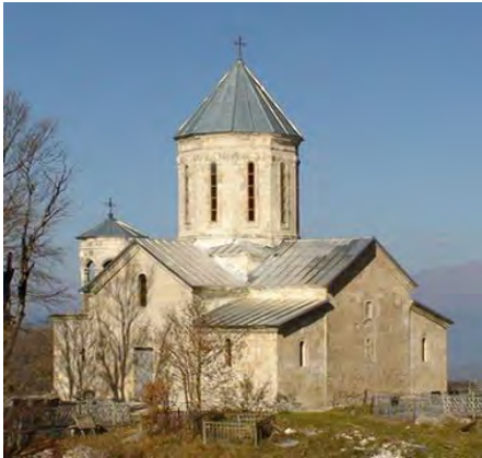
სურ. 3.87.1. საერთო ხედი
