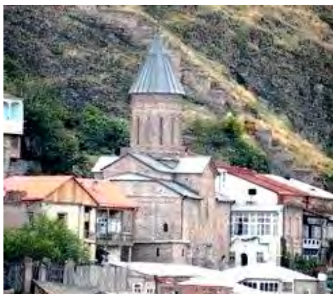
სურ. 3.145.1. საერთო ხედი
