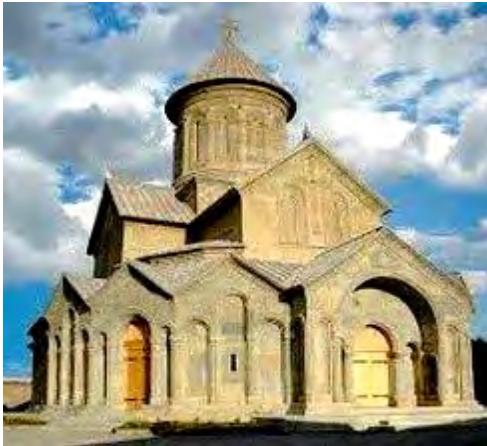
სურ. 3.160.1. საერთო ხედი
