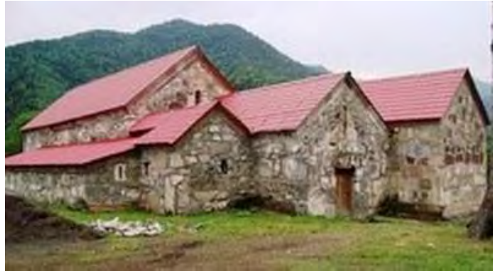
სურ. 3.33.1. საერთო ხედი
