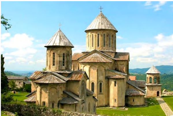
სურ. 3.93.1. საერთო ხედი
