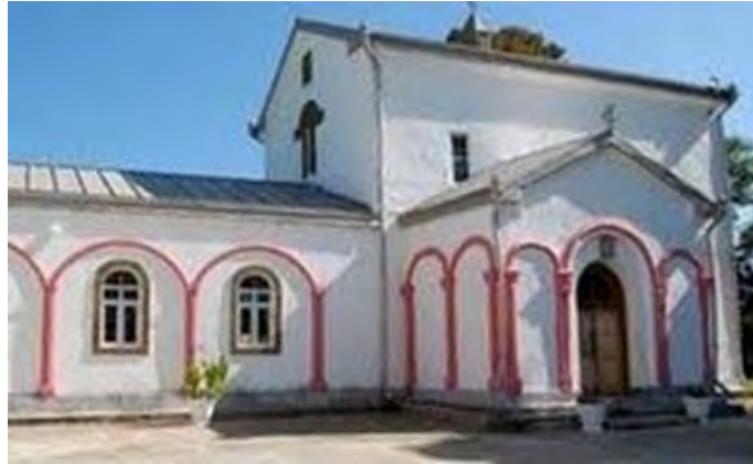
სურ. 3.85.1. საერთო ხედი
