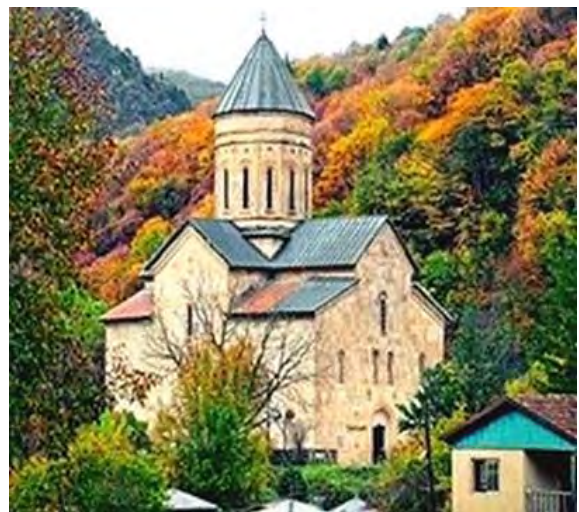
სურ. 3.143.1. საერთო ხედი
