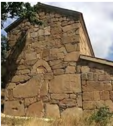
სურ. 3.66.1. საერთო ხედი
