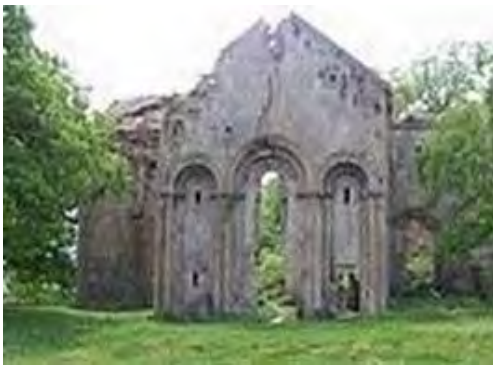
სურ. 3.71.1. საერთო ხედი
