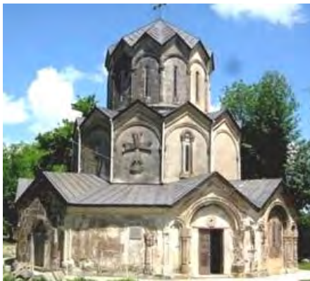
სურ. 3.86.1. საერთო ხედი
