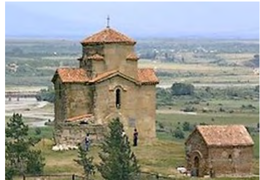
სურ. 3.31.1. საერთო ხედი
