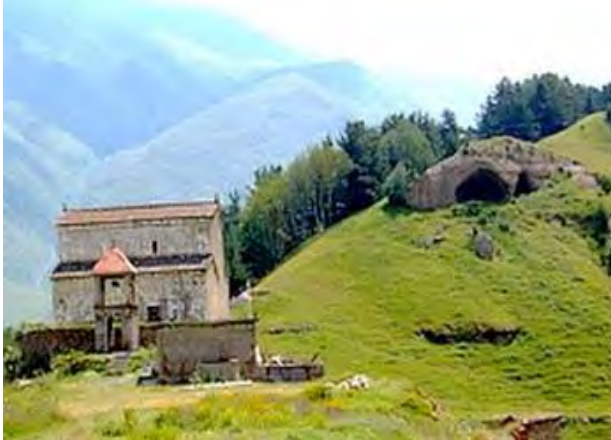
სურ. 3.62.1. საერთო ხედი
