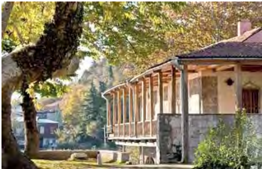
სურ. 4.4.2. საერთო ხედი
