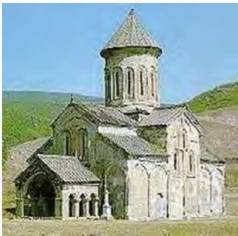
სურ. 3.102.1. საერთო ხედი
