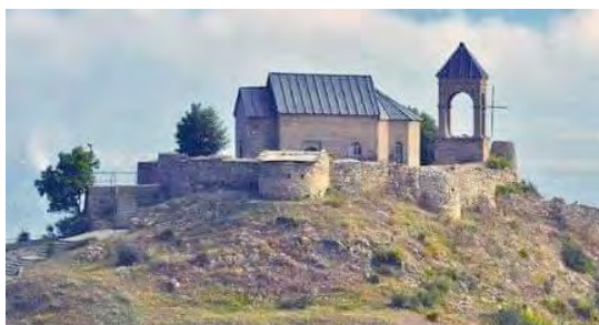
სურ. 3.40.2. საერთო ხედი
