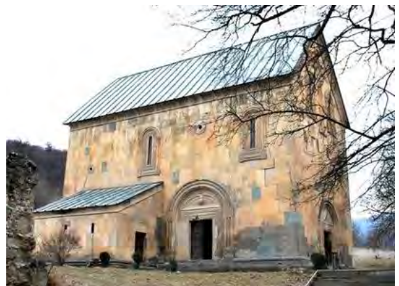
სურ. 3.113.1. საერთო ხედი
