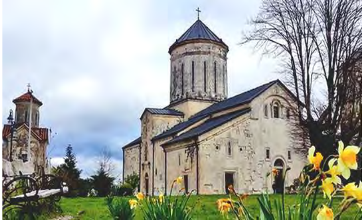
სურ. 3.27.1. საერთო ხედი
