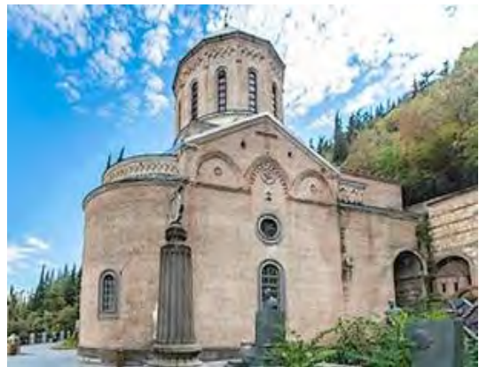
სურ. 3.149.2. საერთო ხედი
