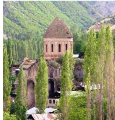
სურ. 3.56.2. საერთო ხედი
