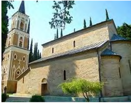
სურ. 3.7.1. საერთო ხედი
