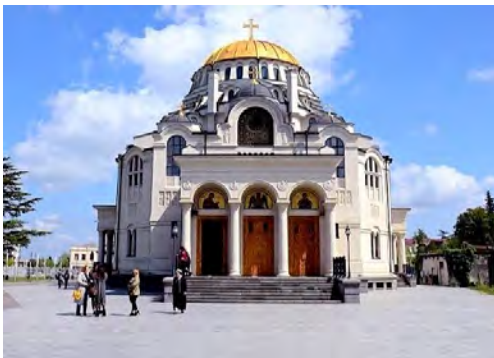
სურ. 3.156.2. საერთო ხედი
