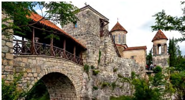
სურ. 3.78.2. საერთო ხედი
