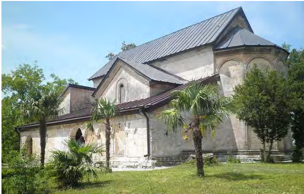
სურ. 3.117.1. საერთო ხედი
