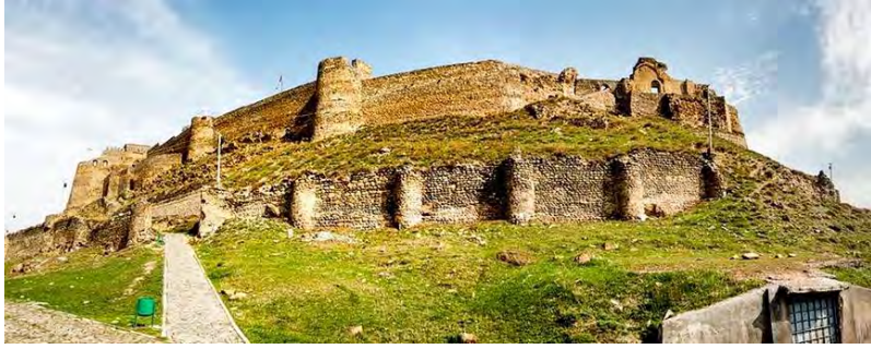
სურ. 3.39.1. საერთო ხედი
