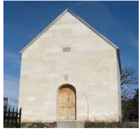
სურ. 3.27.1.1. საერთო ხედი
