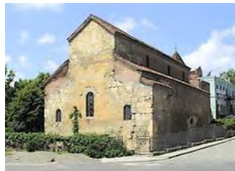
სურ. 3.19.2. საერთო ხედი
