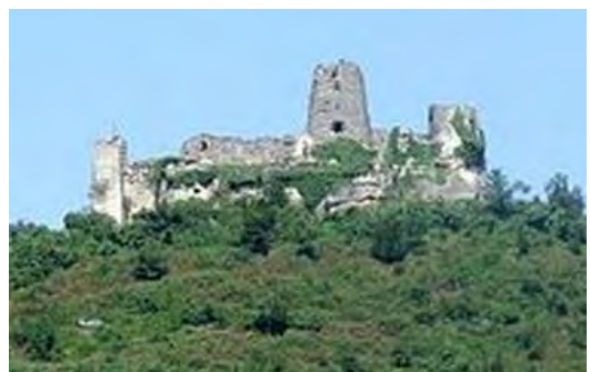
სურ.3.9.2. საერთო ხედი
