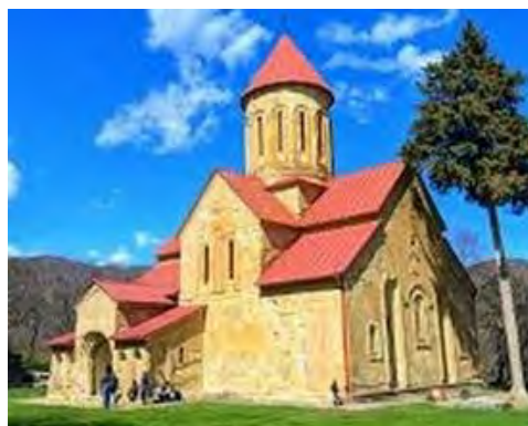
სურ. 3.95.2. საერთო ხედი
