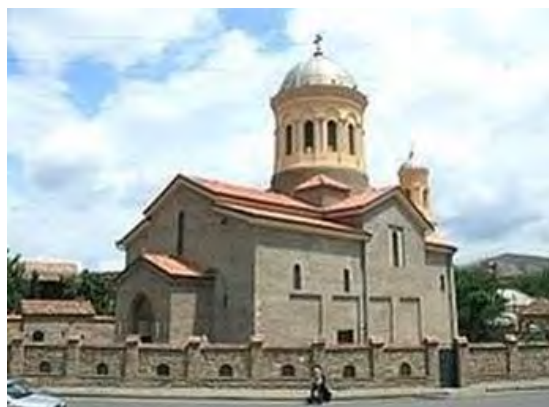
სურ. 3.148.1. საერთო ხედი
