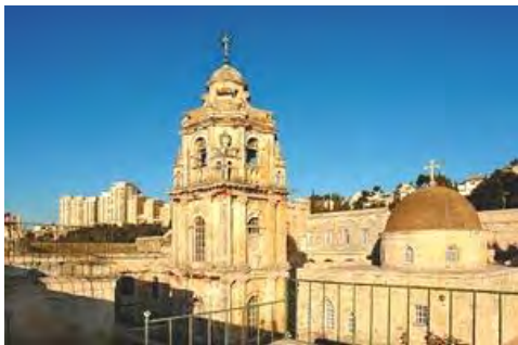
სურ. 3.79.1. საერთო ხედი
