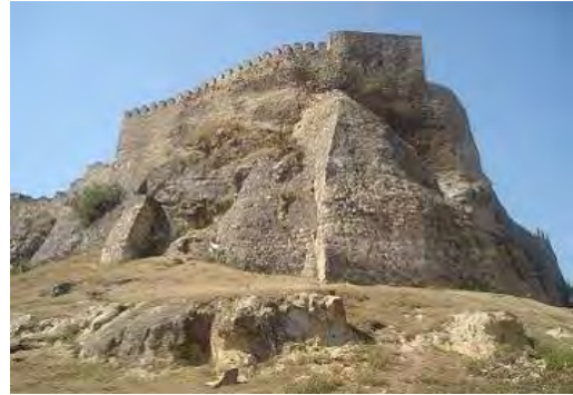
სურ. 3.80.2. საერთო ხედი
