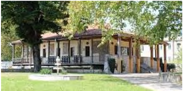
სურ. 4.4.1. საერთო ხედი
