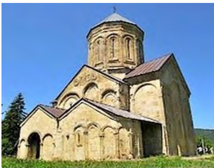
სურ. 3.75.1. საერთო ხედი
