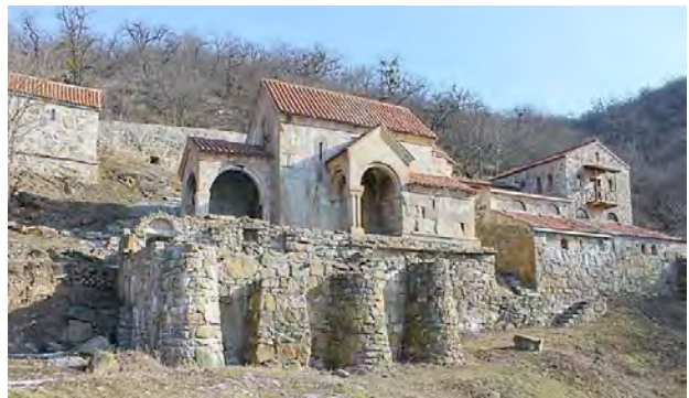
სურ. 3.105.1. საერთო ხედი
