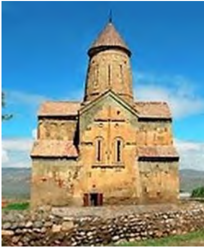
სურ. 3.119.1. საერთო ხედი
