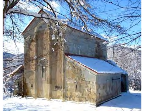
სურ. 3.107.1. საერთო ხედი
