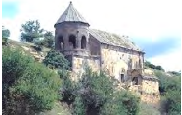
სურ. 3.125.1. საერთო ხედი
