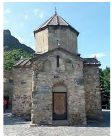
სურ. 3.29.1. საერთო ხედი
