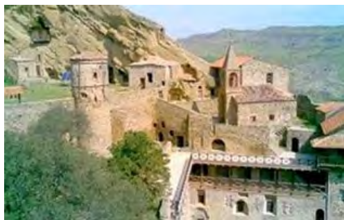
სურ. 3.20.1. საერთო ხედი
